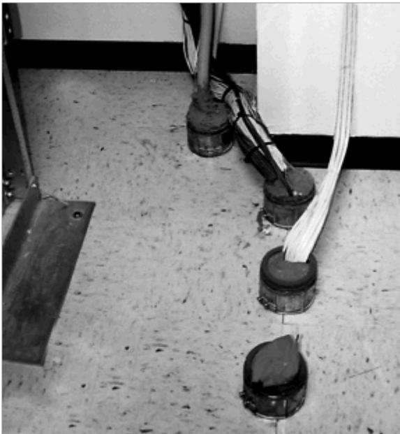
Los cableados en planta interna requieren sistemas corta fuegos en cada uno de los ingresos de los cables en las paredes y techos. Además, los sistemas corta fuegos para las telecomunicaciones deben cumplir con las normas y estándares
