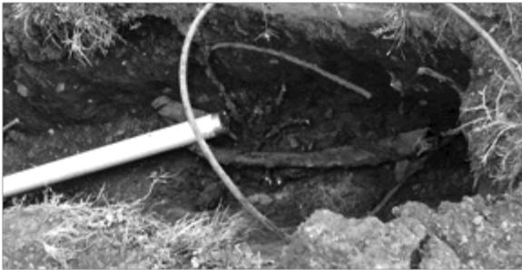
En los Estados Unidos, aproximadamente una vez por día, se rompe un cable de fibra óptica a causa de alguna excavación alrededor del cable, tal como se muestra en la imagen. Los cables en planta interna no son tan vulnerables, excepto por los daños causados por alguna torpeza del personal o durante la extracción de cables abandonados. Toda red es susceptible de sufrir daños, por lo que cada instalación necesita un plan de restauración.
